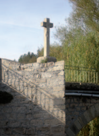
Croix maltée du pont des Salelles 1670
