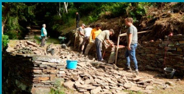
Stage de mur en pierre sèche, le Tournel, Mont-Lozère-et-Goulet
